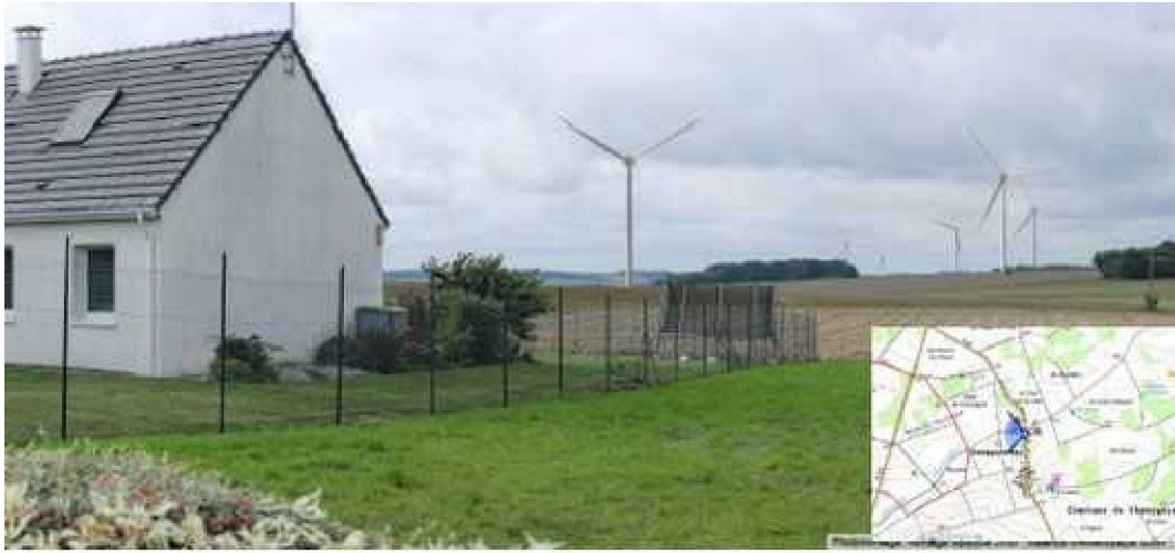
Figure 6: Vue sur le projet depuis Champguyon-Haut
